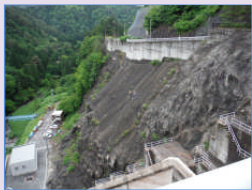
対象モルタル吹付面の状況
