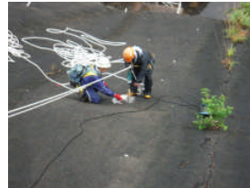
モルタル吹付面でのコア抜き調査
